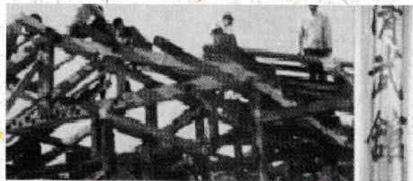
清武館上棟(昭和49年11月)
